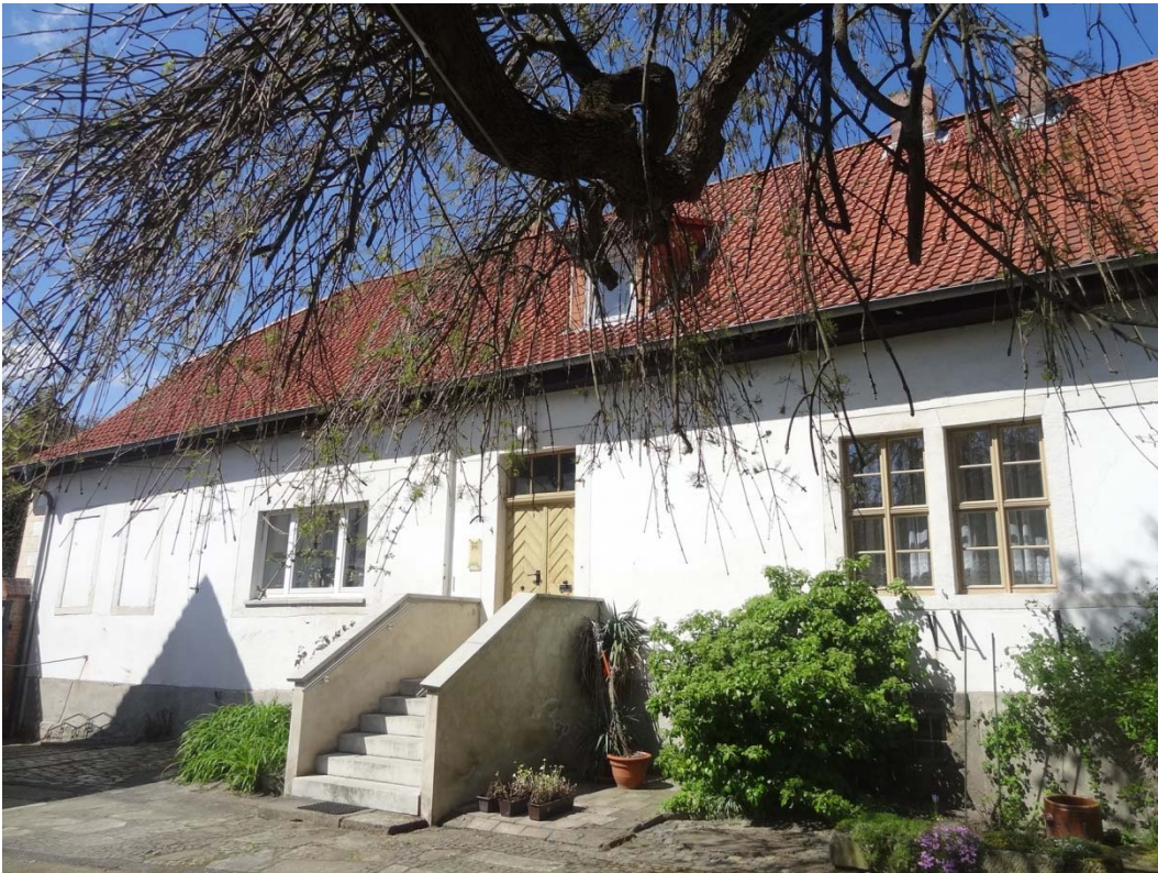
Das alte Pfarrhaus in Ummendorf wird Multiples Haus.
