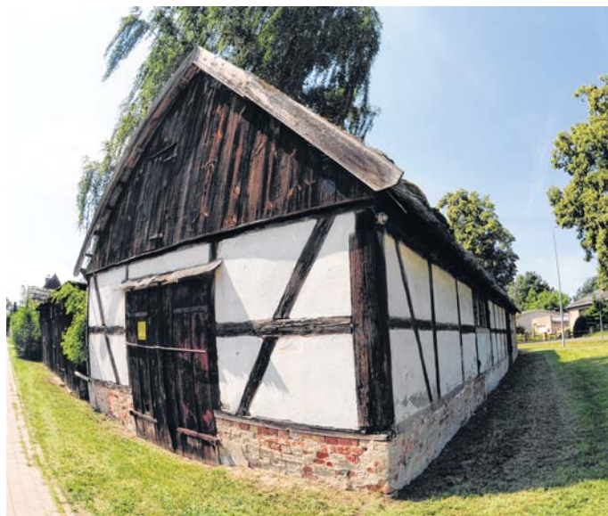
Mit der Sanierung der Alten Mühle in Ahlbeck wird auch für die Region typische Bausubstanz gerettet.
