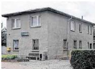
Vereinshaus Böhlitz: Auch hier wäre eine Mehrfachnutzung möglich.
