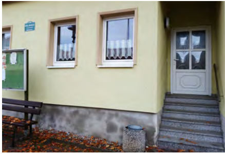
Alte Schule – Bestehender Höhenunterschied Eingang
