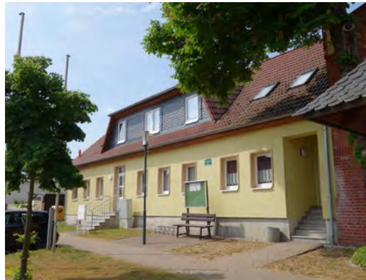
02 Die „Alte Schule“ an der Reesner Dorfstraße
